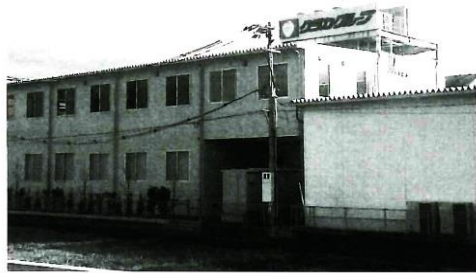
今月末から稼働する新低温貯蔵施設
