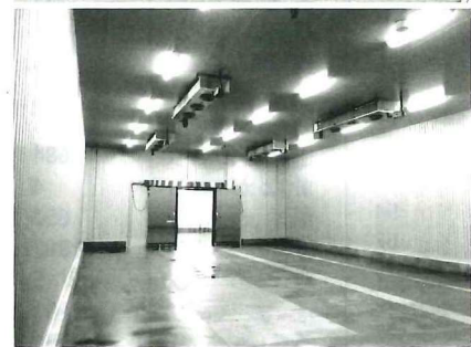
集出荷施設の外観(上)と冷蔵庫
